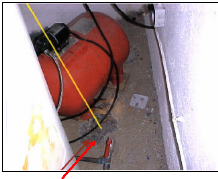
Photo 9: Explosion du béton, chape du surpresseur
