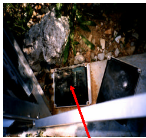
Photo 6: Explosion de la boîte de jonction
